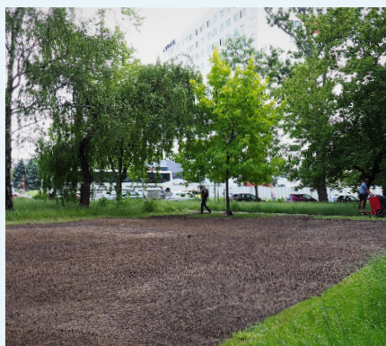
Przygotowanie terenu pod łąkę kwietną
